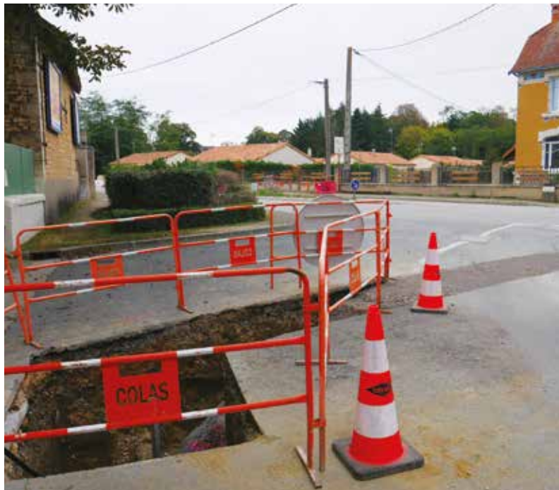
Aperçu du chantier de restructuration du réseau d'eau potable et d'assainissement rue Jean Moulin
